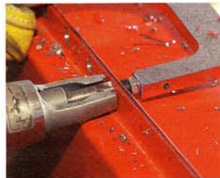
Mit dem Schälbohrer trennt Thomas Geis nur die oberste Blechlage auf. Dann lässt sich...
